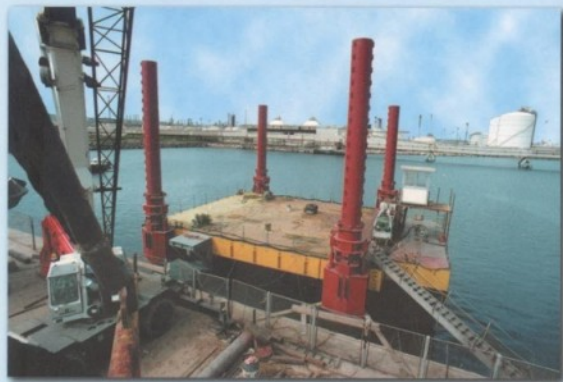
In fase di assemblaggio During assembly
