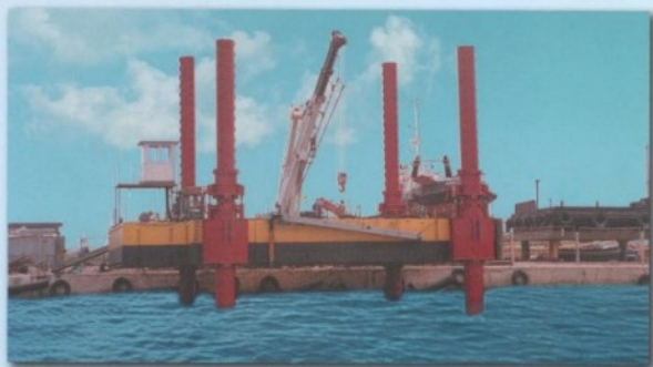
Con gru 90 ton. With 90 ton. crane
